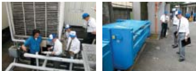
現場監査風景
