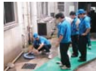
レンズ排水処理施設緊急時訓練
