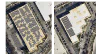
建屋に設置された太陽光発電/TPS (アメリカ)
