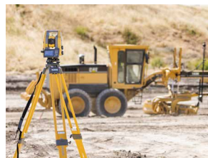
ICT施工システム
