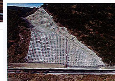
道路法面強化等の緊急対策
