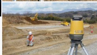
施工現場での使用事例
