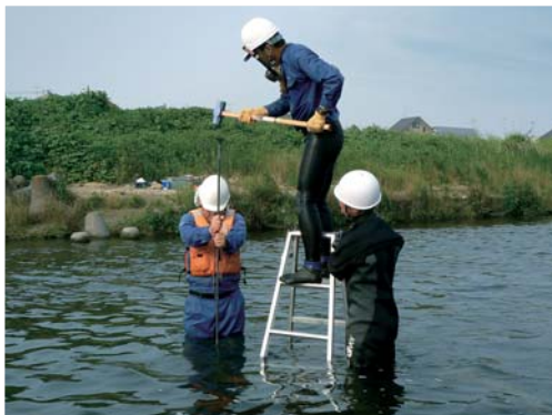
リングを通した鉄杭をハンマーで打ち込むが、川底にはこぶし大の石が沢山あり、打ち込むのも大変だ。1本打ち込むのに2時間程掛かることもあり、時にはハンマー自体折れてしまう。水深が深く流れが早いところでは、その作業はより困難なものになる。
