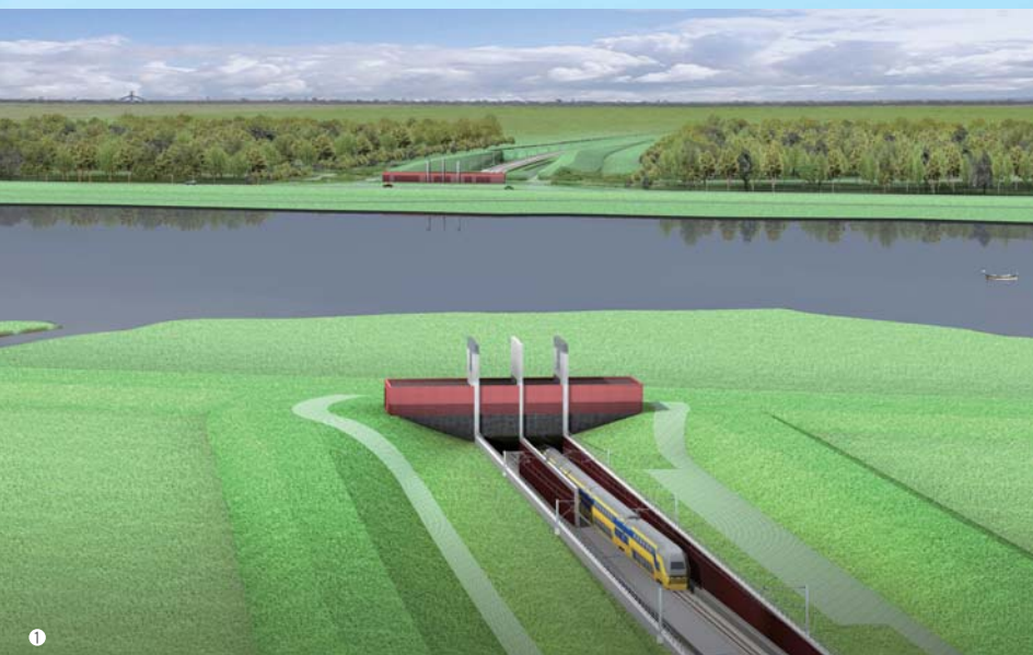
①ドロンテルメール湖の湖底に建設が予定されている長さ800mのトンネル（レンダリング画）②「GSR2700 ISX」GPS/GNSS受信機のレクチャーを受けるプリズマ社のグレッグ・バーネット様（左）と、現地ソキア代理店の担当営業者（右）。③360°プリズムを自動追尾する「SRX」を使えば、1人で測量作業を行える。④ドロンテン近くで6メートルの盛土を形成する作業で使用されているトータルステーション「SRX」。背景では、ゾイデル湖から採取された細かな砂がパイプラインを通して用意された型枠に直接送り込まれる。沈殿し締められることで、ハンゼ線の2階建列車に適した堅い路床ができあがる。⑤ズウォレ近くのアイセル川に建設予定の長さ1kmの建替え鉄道橋（レンダリング画）
