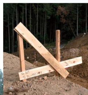
丁張は、法長・勾配・測点、高さを示す法面施工の“物差し”。ミリ単位の精度が要求される位置出し・管理で、『SRX』が大幅な省人化・効率化を実現した。
