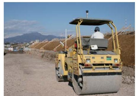
極的な活用を見据えている。「今回GPSではなくトータルステーションを採用したのは、盛土完了後の出来形管理も行うため。トータルステーションの利用は、従来法と比べれば格段に作業効率はアップしたが、一方で、事前のデータ入力、現場での基地局設置やバッテリー交換・プリズム捕捉などの実務作業がより簡便になれば、さらに効果は上がると思う」と、監理技術者の慎重な口ぶりの中にも新しいシステムへの期待感が表れていた。
