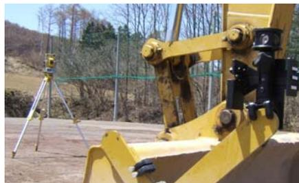
バックホウのバケットに取り付けたプリズムをGPT-9000Aで観測し、位置情報を取得。運転席側にデータコレクタを設置し、設計図面上のバケット位置と切盛り差を表示させ、表示に合わせてオペレータがバケットの操作を行う。常田社長はこのシステムのメリットを次のように説明する。「従来は杭が打ちにくい硬い岩盤や急斜面に丁張りを掛けるのがとても大変でした。しかし、このシステムを使うことで丁張りの必要がなくなり、少ない人手で短時間に施工できるようになりました」。その結果、測量から設計・施工までのトータルで、50%ものコストが削減できたのだという。また「設計図面上の現在位置が3次元でわかるので、Pocket-3Dはとても使いやすい。このシステムにはなくてはならない理想的なソフトです。またGPT-9000Aはプリズムを自動で追尾してくれる
