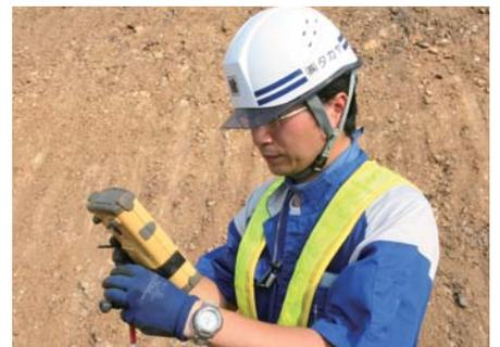
面で素早い対応ができるISはきわめて有効です。現況・横断測量にかかる時間は今までの半分に、図面化など事務所で2日間かかっていたデータ処理は1時間でできるようになりました」と、田村様は工期の大幅な短縮が実現できたことを実感している。同社ではISによる高効率な施工管理システムがNETISに登録されていることに注目し、この手法を同社の技術提案に積極的に盛り込む取り組みを進めている。
