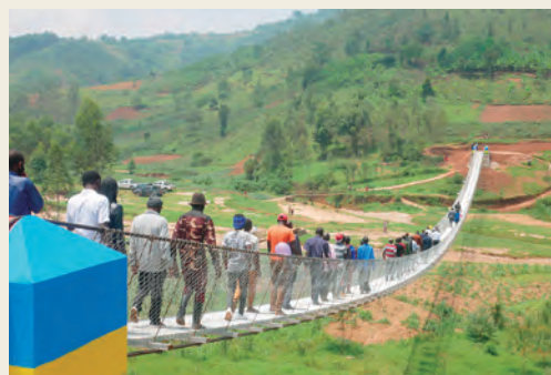
完成した人道橋
