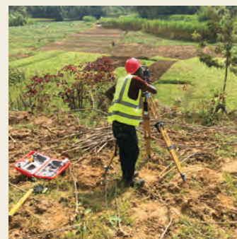
3次元計測機器による測量
