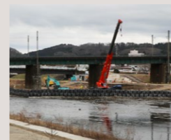
河川 (法面整形)
